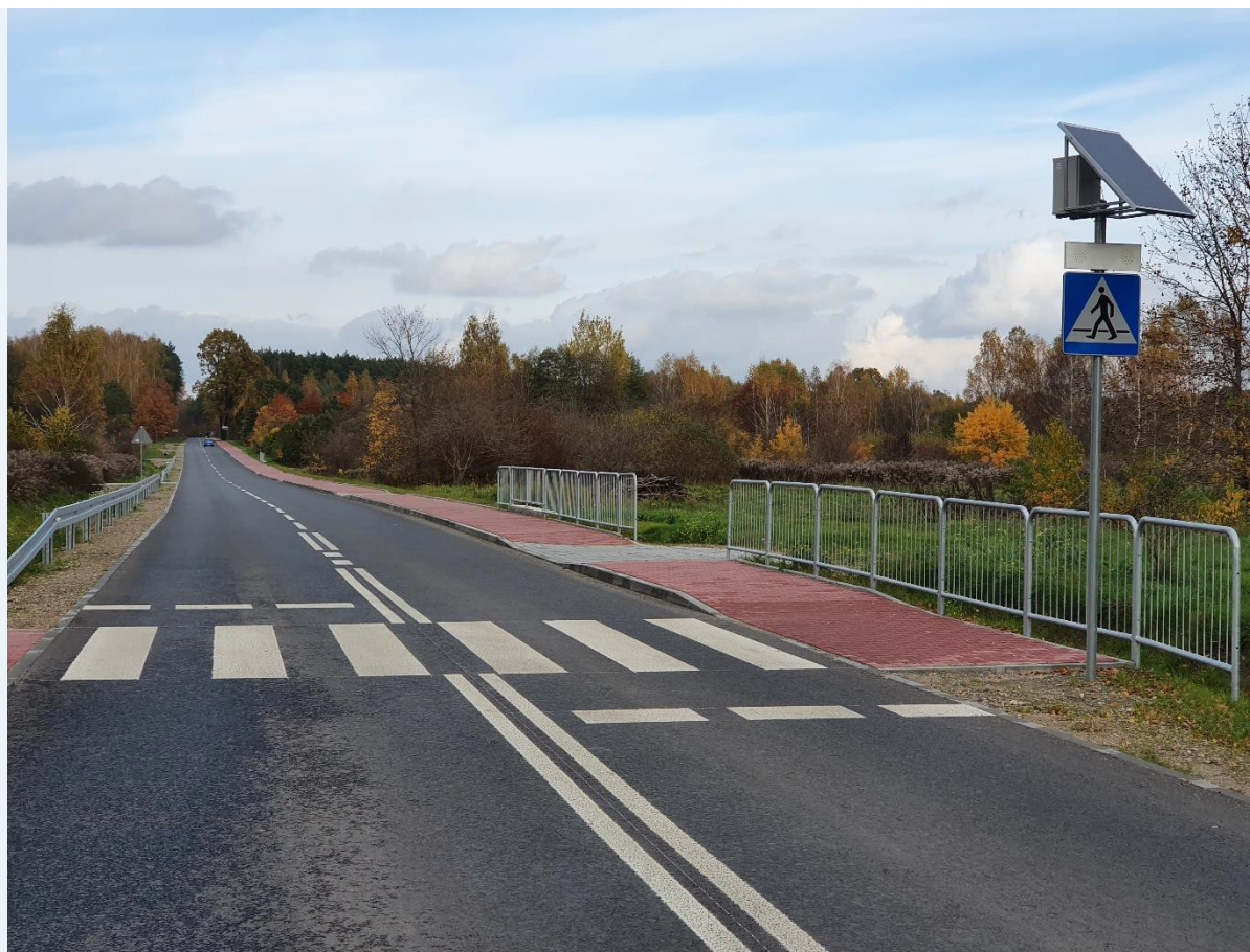
Droga powiatowa nr 1504W po zakończeniu inwestycji
