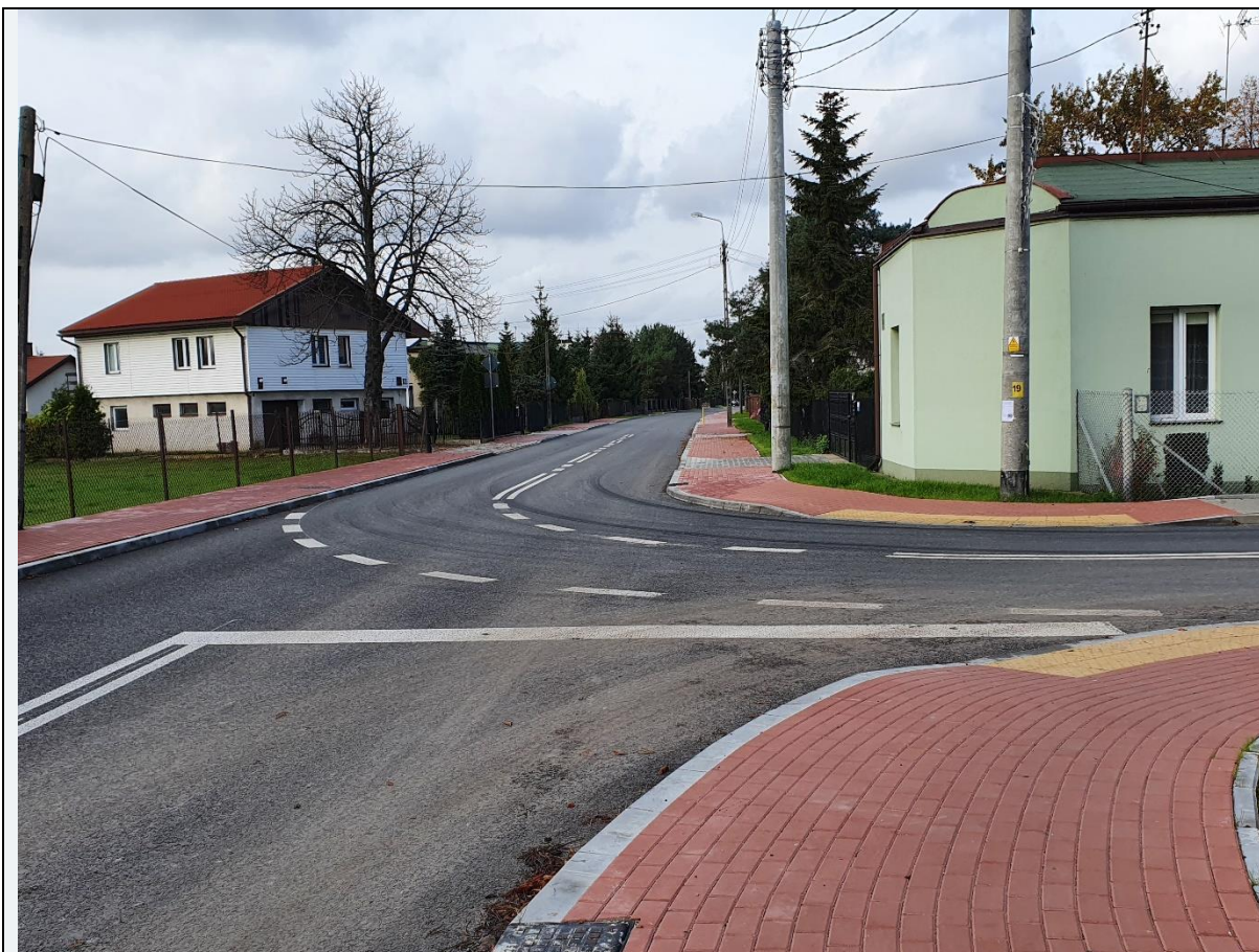
Ulica Pomorska na terenie gminy Jaktorów po zakończeniu inwestycji
