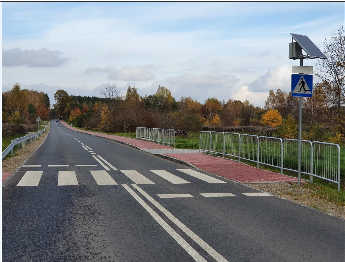
Droga powiatowa nr 1504W po zakończeniu inwestycji
