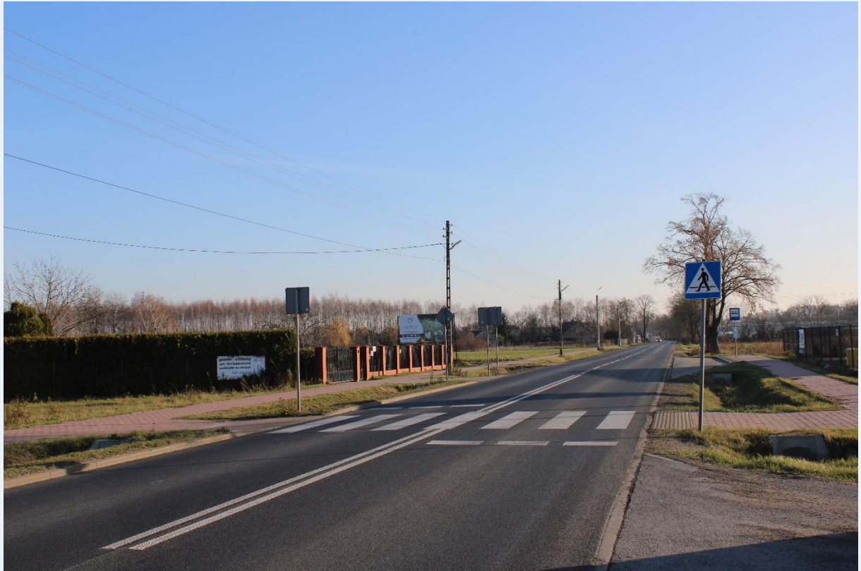
Droga powiatowa nr 1503W po zakończeniu inwestycji
